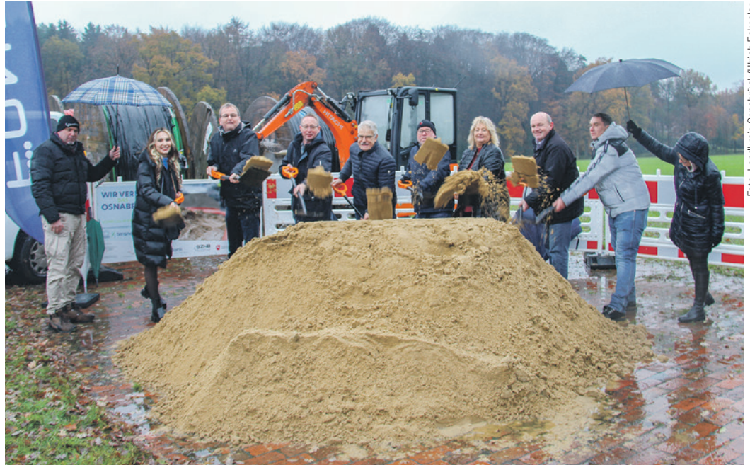
Offizieller erster Spatenstich zur Beseitigung von »Weißen Flecken« in Merzen und Voltlage: Eine Vielzahl von Beteiligten, darunter Vertreter aus Landkreis, Gemeinden und Baufirmen, starten gemeinsam das Breitbandprojekt.
